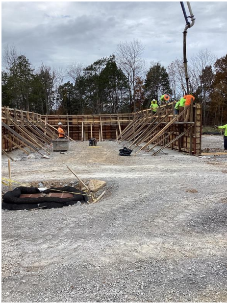
Description: Wall pour Image Date Taken: 10/27/2023 Photographer: Miller, Kevin
